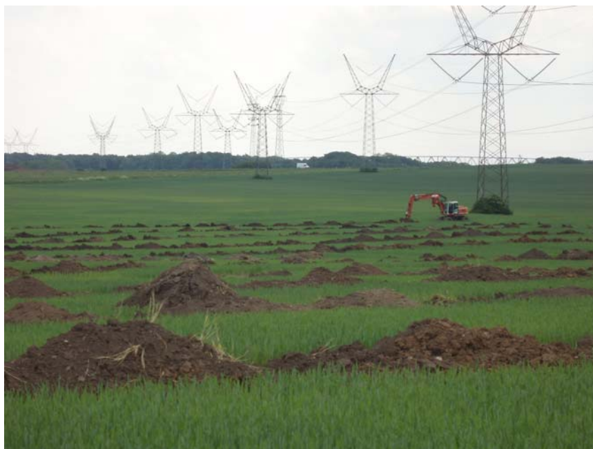
Fig 3: Udgravningsfeltet med Lillebæltsbroen i baggrunden.
